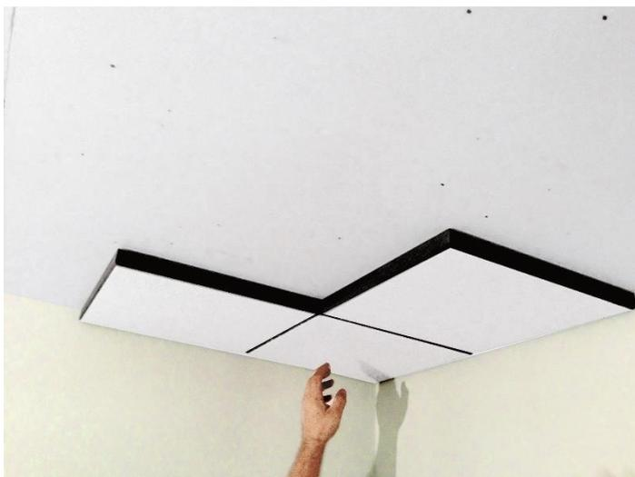
Abbildung 15: Dämmung der Kellerdecke (BAUHAUS Fachcentren AG)
