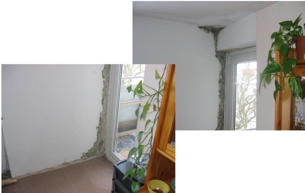
Abbildung 21: Schimmelbildung bei Wärmebrücken (Bild: © F. Zeitler)
