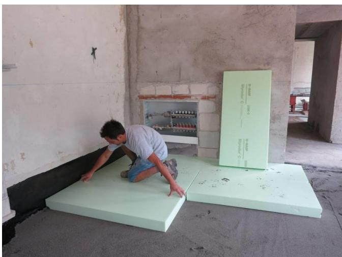
Abbildung 17: Dämmung der Bodenplatte (Bild: Oscar Stuffer Solarraum)
