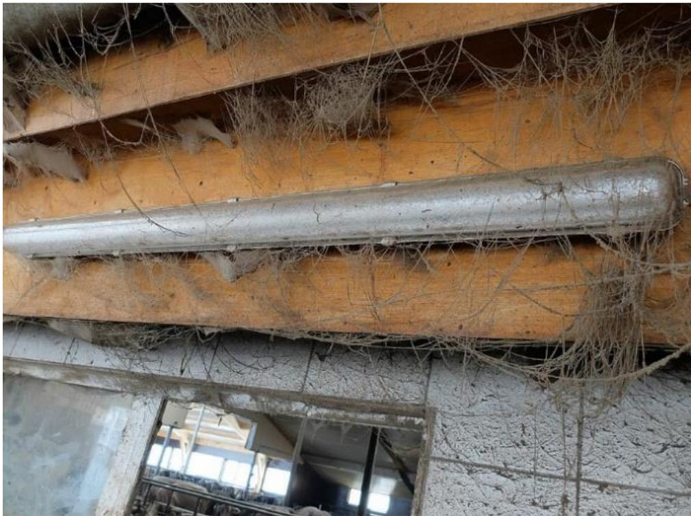
Abbildung 2: Bildung von Staub und Spinnennetzen im Stallbereich (Bild: Hermann Willfarth)
