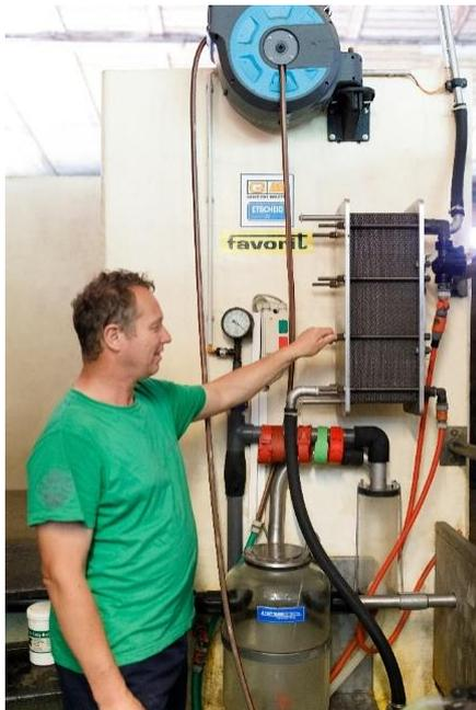
Abbildung 5: Milchvorkühlung mit Plattenwärmetauscher (Bild: LK Steiermark)
