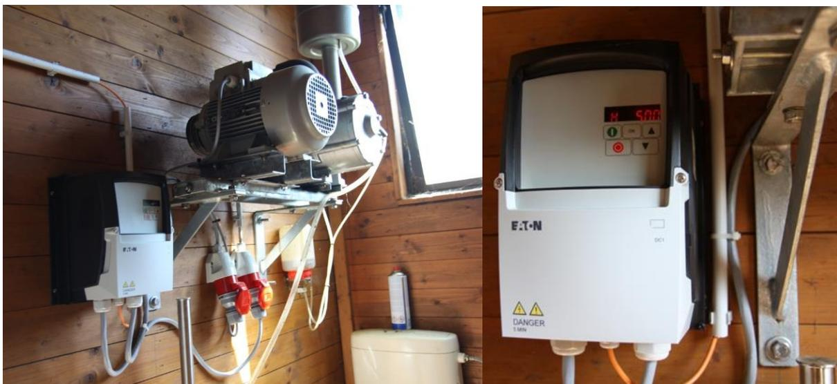
Abbildung 3: Nachrüstung einer Frequenzsteuerung bei einer 3,5 kW Westfalia Vakuumpumpe (Bild: LK Steiermark)
