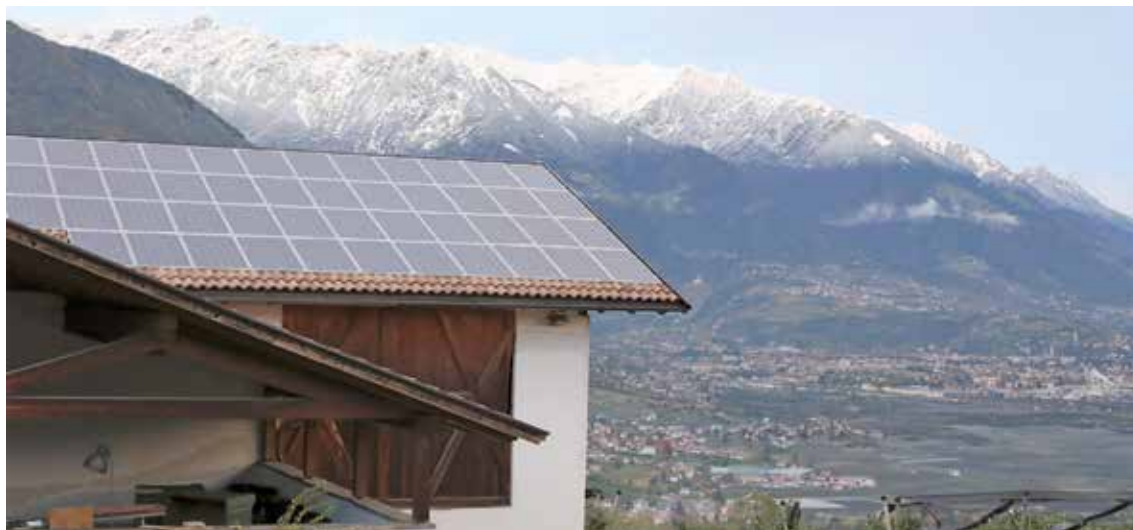
Anlage auf landwirtschaftlichem Gebäude (Quelle: SBB)
