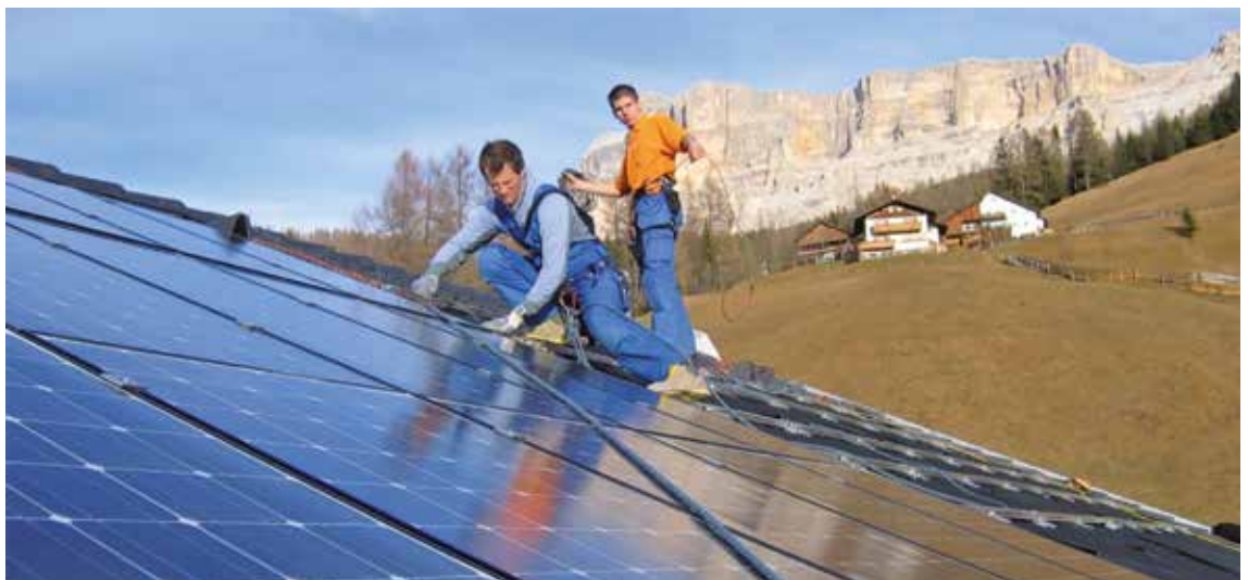
Montage einer PV-Anlage (Quelle: PVEnergy)
