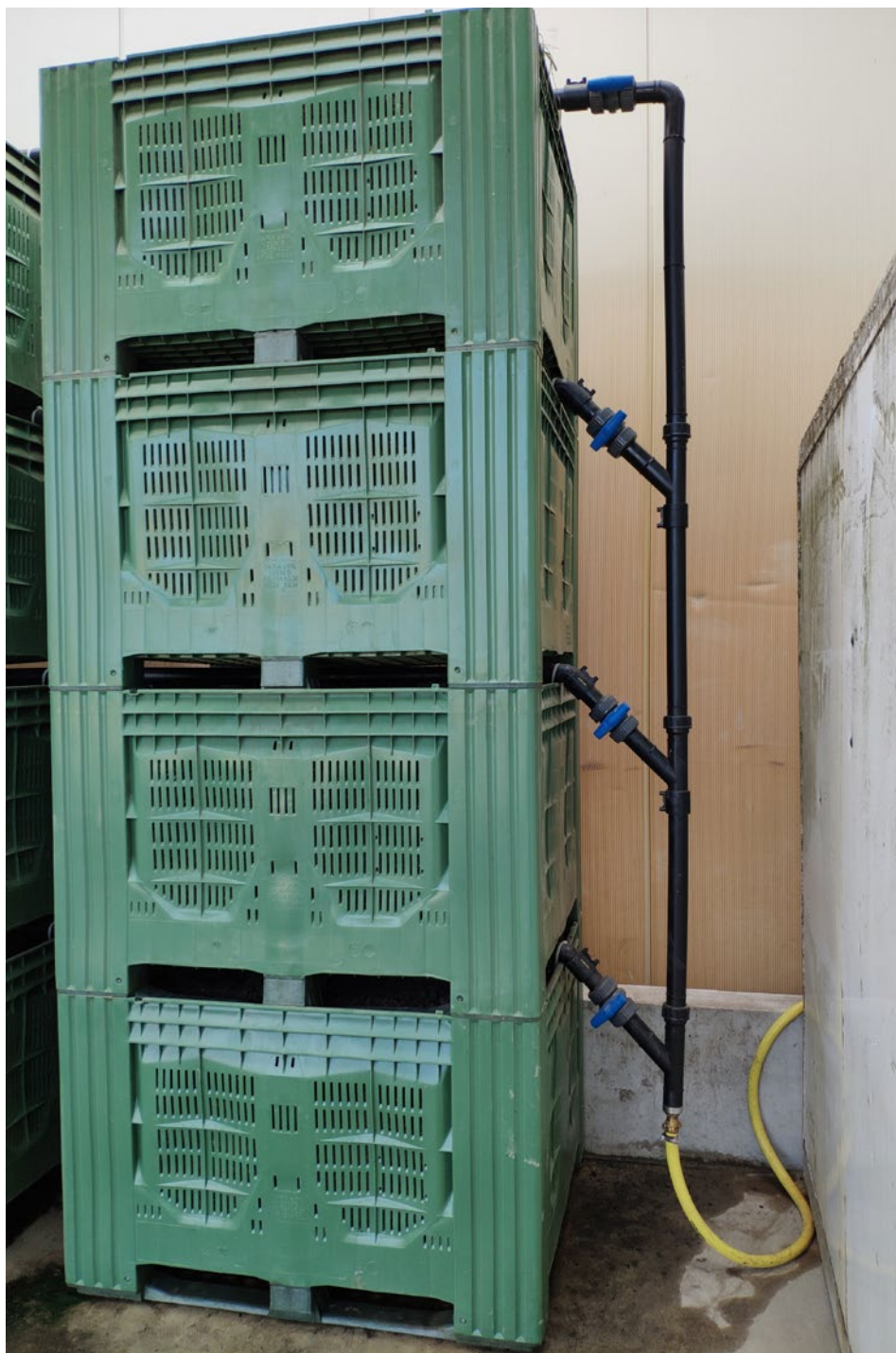
Immagine 17: Sistema di evaporazione biologico verticale (Berna, Svizzera)
