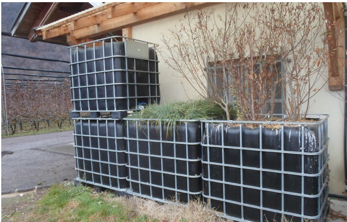
Immagine 15: Biofiltro presso il Centro di Sperimentazione Laimburg, costruzione propria secondo le istruzioni di Pcfruit (Belgio)
