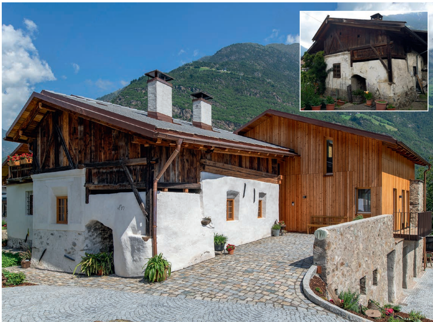
Altes sanieren, um darin modern und behaglich zu wohnen: Das ist die Herausforderung bei der Bauernhaus-Sanierungsberatung.
