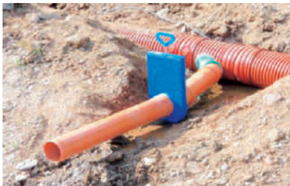
Abb. 12: Wasserzulauf als unterirdisch verlegtes Rohr mit Schieber zum Sperren oder zur Mengenregelung des Zuflusses
